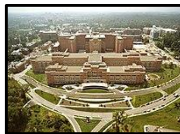
NIH 本部のクリニカルセンター
